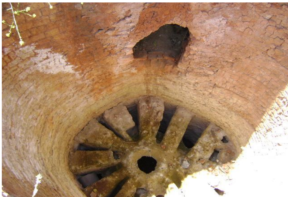
منظر لغرفة الحرق
