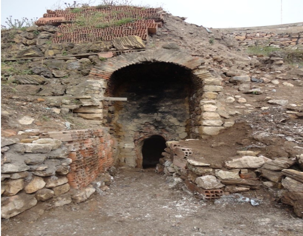
الفرن بعد التنظيف و الترميم (فتحة الموقد)
