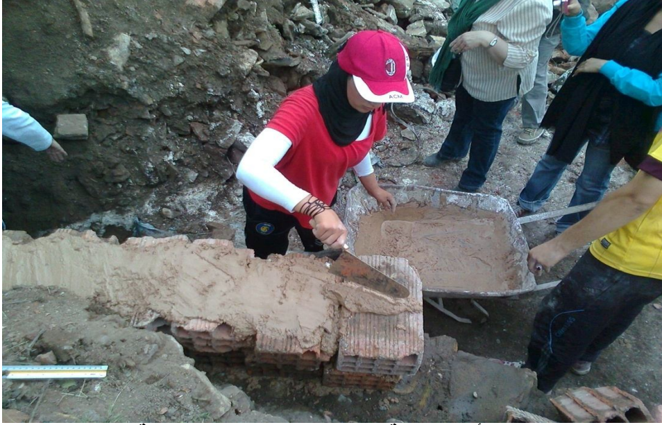
الفرن أثناء عملية الترميم (استعمال الماد المحلية)
